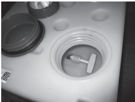
Fig. 99: Bundprop i drikkevandstanken
