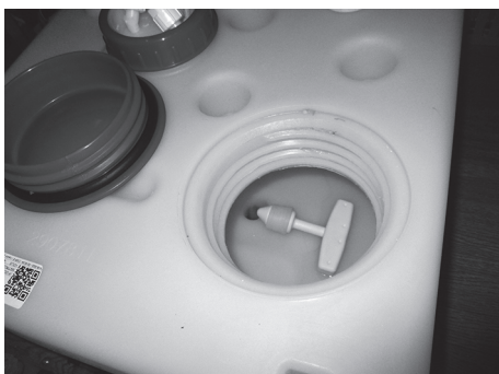
Fig. 109: Bundprop i drikkevandstanken
