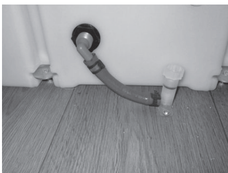
Fig. 93: Tømmeventil, eksempel
