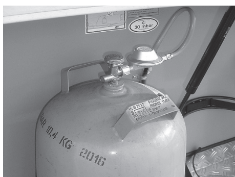
Fig. 110: Gasflaske med trykreduktionsventil
