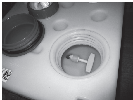
Fig. 95: Bundprop i drikkevandstanken
