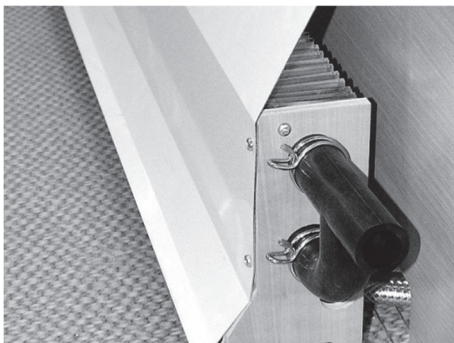
Fig. 87: Konvektor med varmeledeplade
