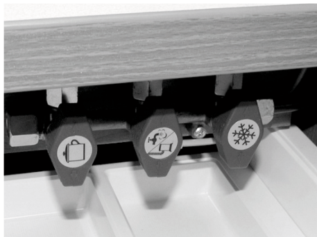
Afb. 69: Snelsluitkranen
