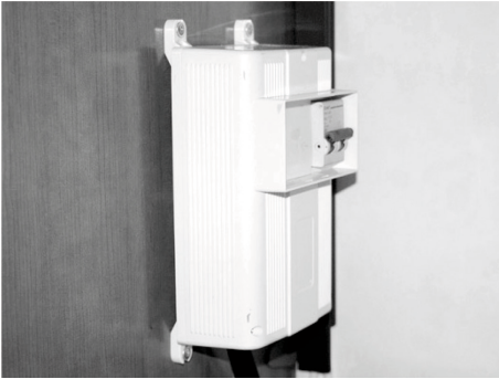
Afb. 59: Hoofdschakelaar (FI-contactverbreker)
