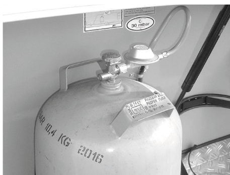
Afb. 71: Gasfles met lagedrukregelaar en lagedrukslang
