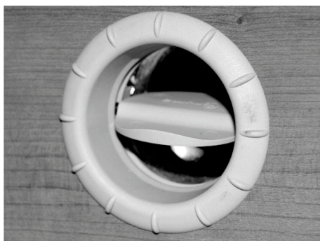
Bild 72: Varmluftspjäll, öppet
