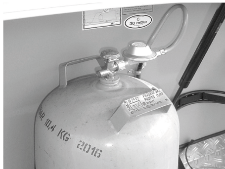
Afb. 64: Gasfles met lagedrukregelaar en lagedrukslang
