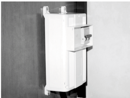
Afb. 3: Hoofdschakelaar (FI-contactverbreker)
