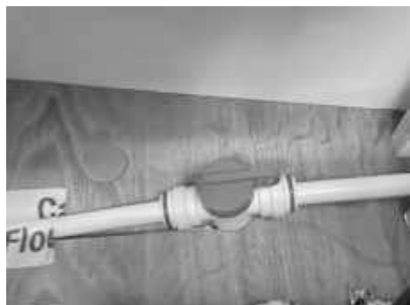
Afb. 86: Klep voor ALDE-vloertemperatuurregeling
