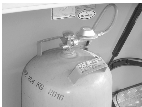
Afb. 108: Gasfles met drukverminderingsklep
