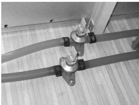
Afb. 97: Aftapkranen open
