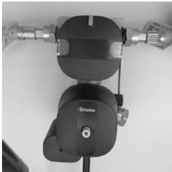
Afb. 71: Gasinstallatie (met Eis-Ex en display op afstand)
