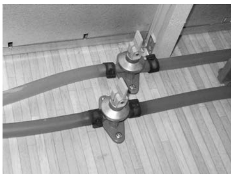
Fig. 97: Åbn aftapningsventilerne.
