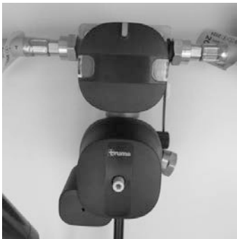
Fig. 109: Gasanlæg DuoControl CS
