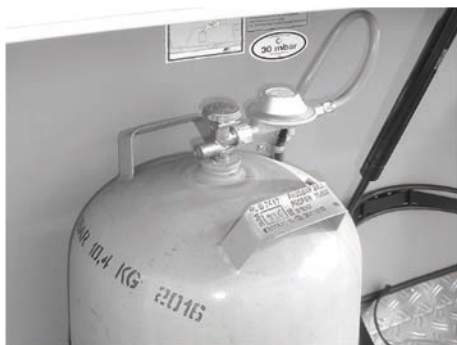
Fig. 70: Gasflaske med lavtryksregulator og lavtryksslange
