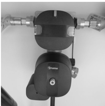
Afb. 114: Gasvoorziening DuoControl CS
