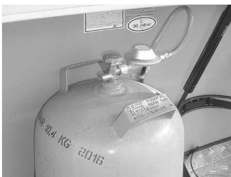
Afb. 112: Gasfles met drukverminderingsklep
