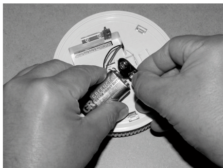
Bild 120: Byte av batteri
