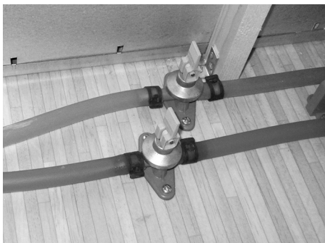
Fig. 100: Åbn aftapningsventilerne.
