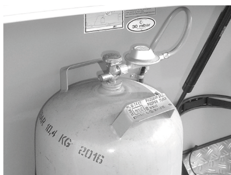
Fig. 77: Gasflaske med lavtryksregulator og lavtryksslange
