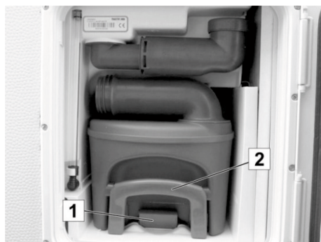
Fig. 172: Toilettank i tømmeskakten
