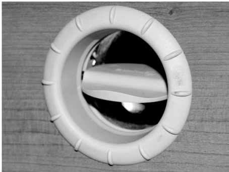
Bild 83: Varmluftspjäll, öppet
