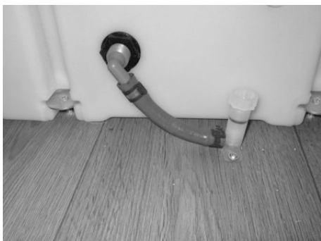
Bild 95: Avtappningsventil, exempel
