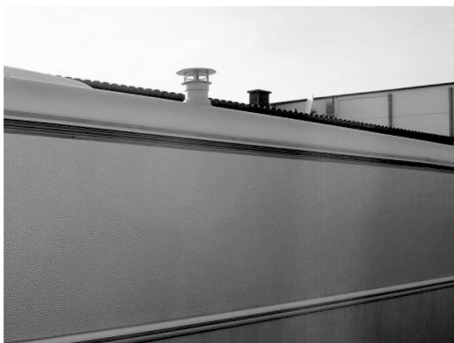
Bild 84: Gasolvärmeaggregatets skorsten
