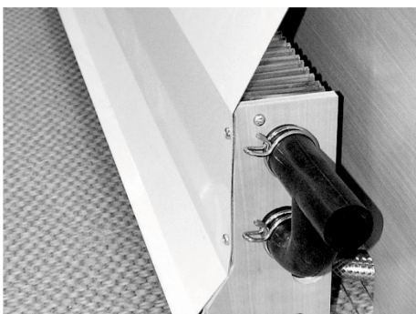
Bild 89: Konvektor med värmeledningsplåt
