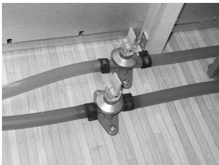
Bild 100: Avtappningsventilen öppen
